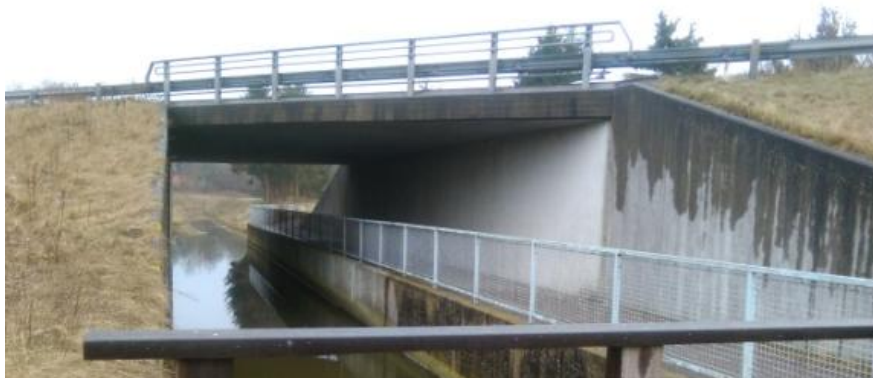
Billede 3: Åen løber i en "betonkasse" under vejen
