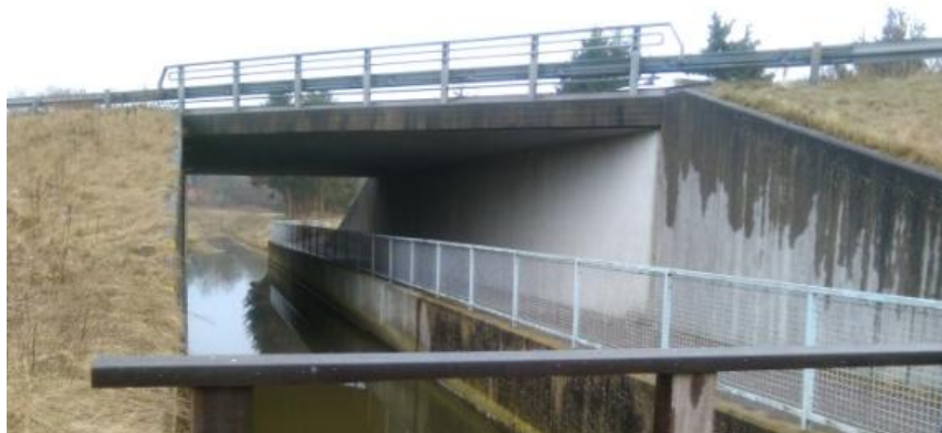
Billede 6: Åen løber i en "betonkasse" under vejen
