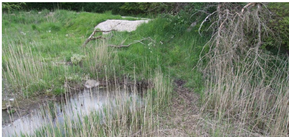
Figur 3-4: Dæmning på tværs af grøften mod nord.
